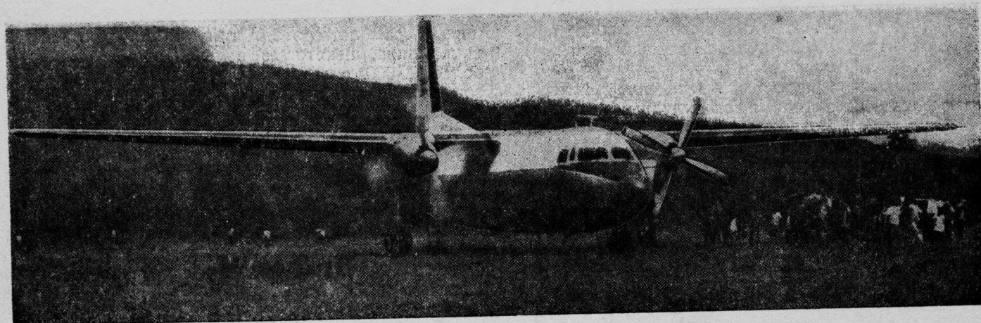
Рис. 2. Самолет Фоккер F-27 «Френдшип», срок службы которого может быть увеличен до 90 000 полетов, эксплуатируется с обычных, плохо подготовленных летных полос
