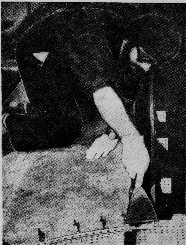
Рис. 5. Клеевая смесь холодного отверждения накладывается на хорошо подготовленные подогнанные поверхности, образующие продольный стык фюзеляжа (опыт фирмы Фоккер)
